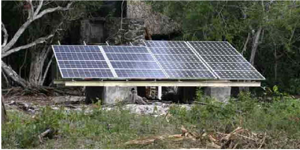
Fig. 9 Paneles solares : adquisición de 10 paneles solares.
