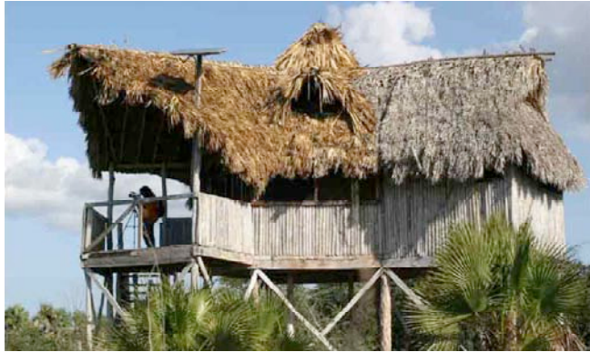
Fig. 1 Cabaña Ingram : restauración de la parte delantera del techo con guano.
