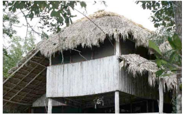
Fig. 2 Estación : restauración de la parte superior del techo con guano.
