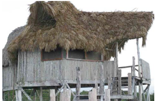
Fig. 4 Cabaña Dr. Arturo Gómez-Pompa : restauración de la parte delantera del techo con guano
