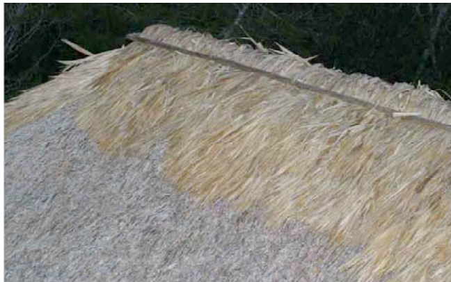
Fig. 3 Estación : restauración de la parte superior del techo con guano. (Vista desde arriba)
